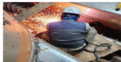
SRF SCREW BLADE 및 SPROCKET 교체작업
