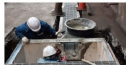
공장 내 배수로 보수 및 PIT 개선작업
