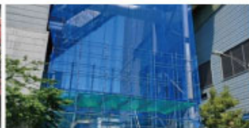
이중플렉스 A,B호기 오버홀 작업
