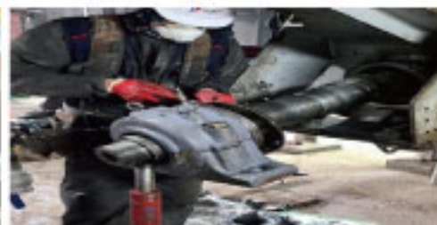
바닥재 배출 및 이송컨베이어 오버홀 작업
