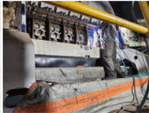
가연물분쇄기 (연간계약) 오버홀 공사
