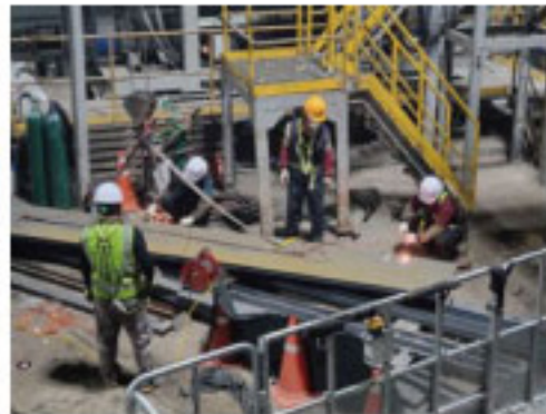
안전시설물 구조물 공사
