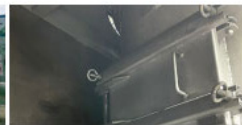
회수기 호퍼 점검창 설치 작업
