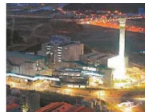
발전 설비 공사
