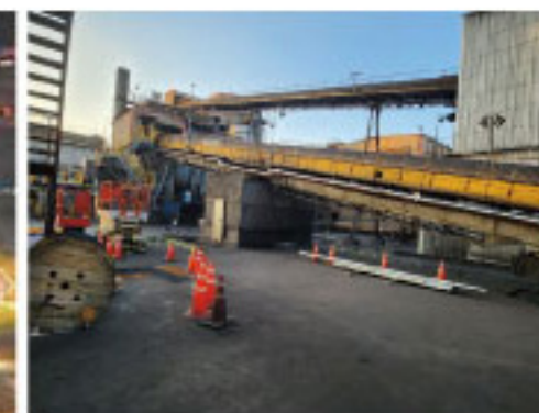
제철 설비 공사
