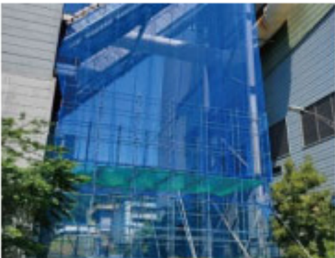
이중플렉스 오버홀 공사
